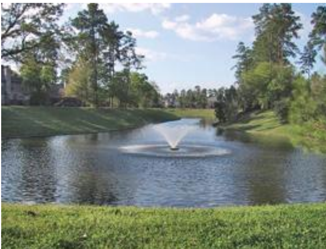
Figura 2.6 – Bacia de Retenção. (Fonte: The Journal for Surface Water Quality Professionals Stormwater.)
