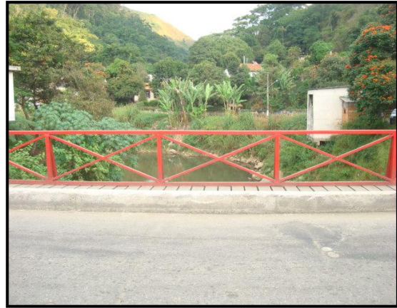
Figura 4.30 – Ponto 1, vista para montante.
